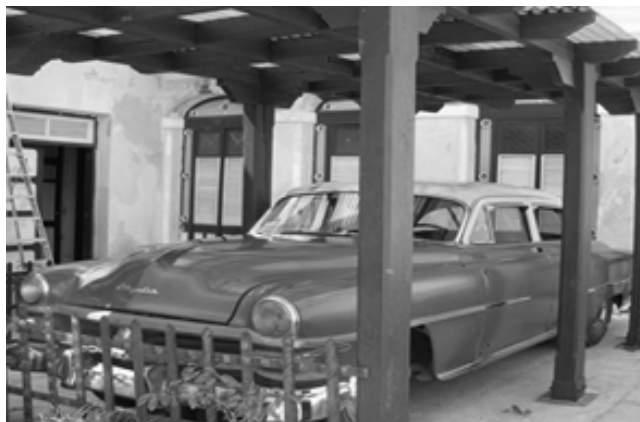
Figura 2. Estructura de la pérgola que protege el automóvil.
